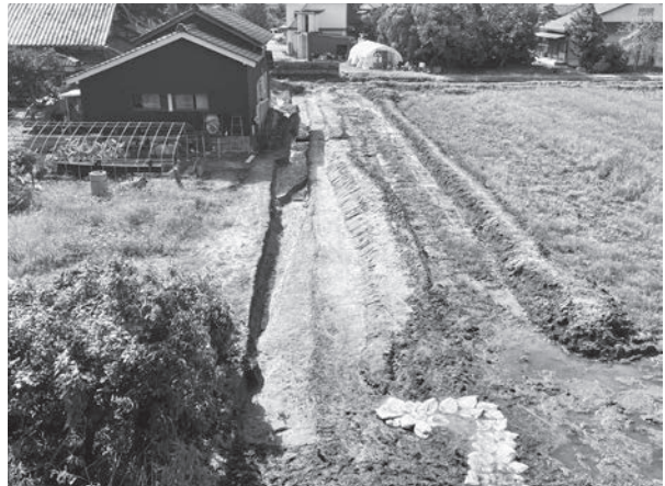
B地区全景（東から）
